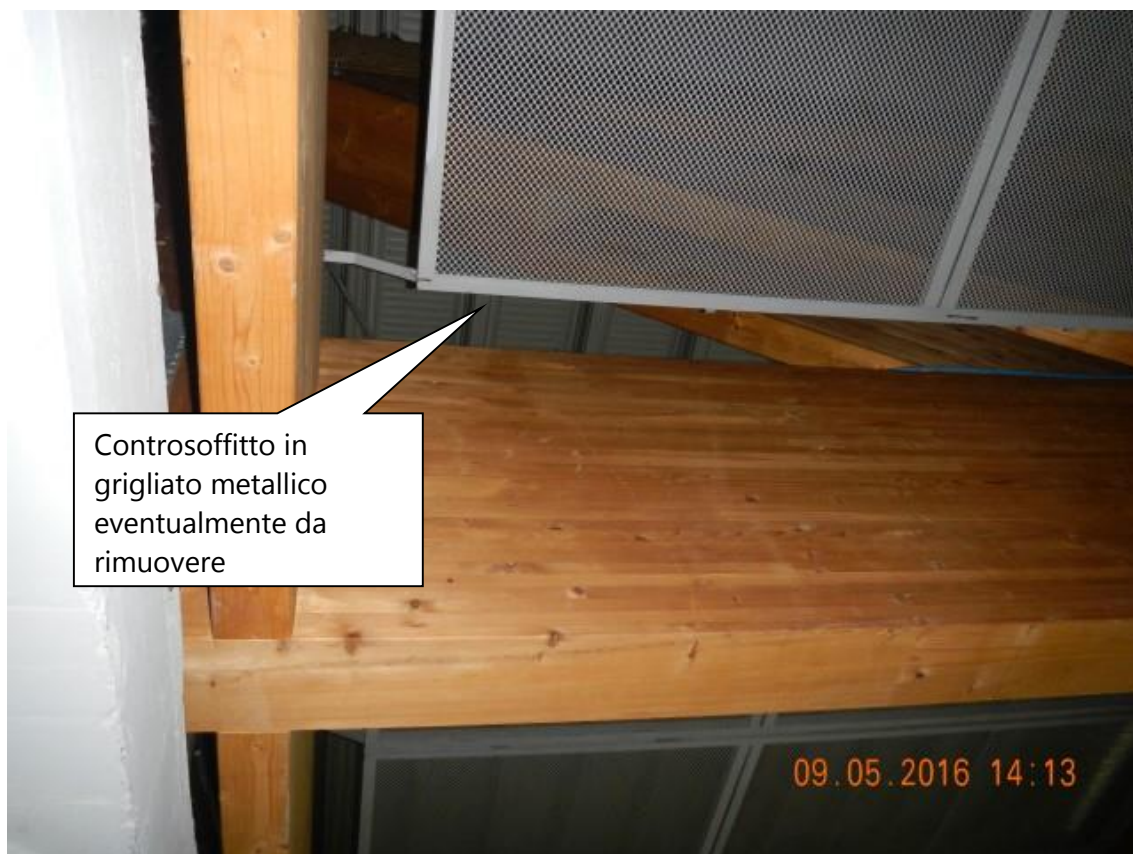
Figura 34. Controsoffitto in grigliato metallico.
