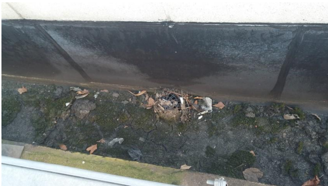
Figura 24. Esempio di canale di gronda e relativo imbocco del pluviale oggetto di impermeabilizzazione.
